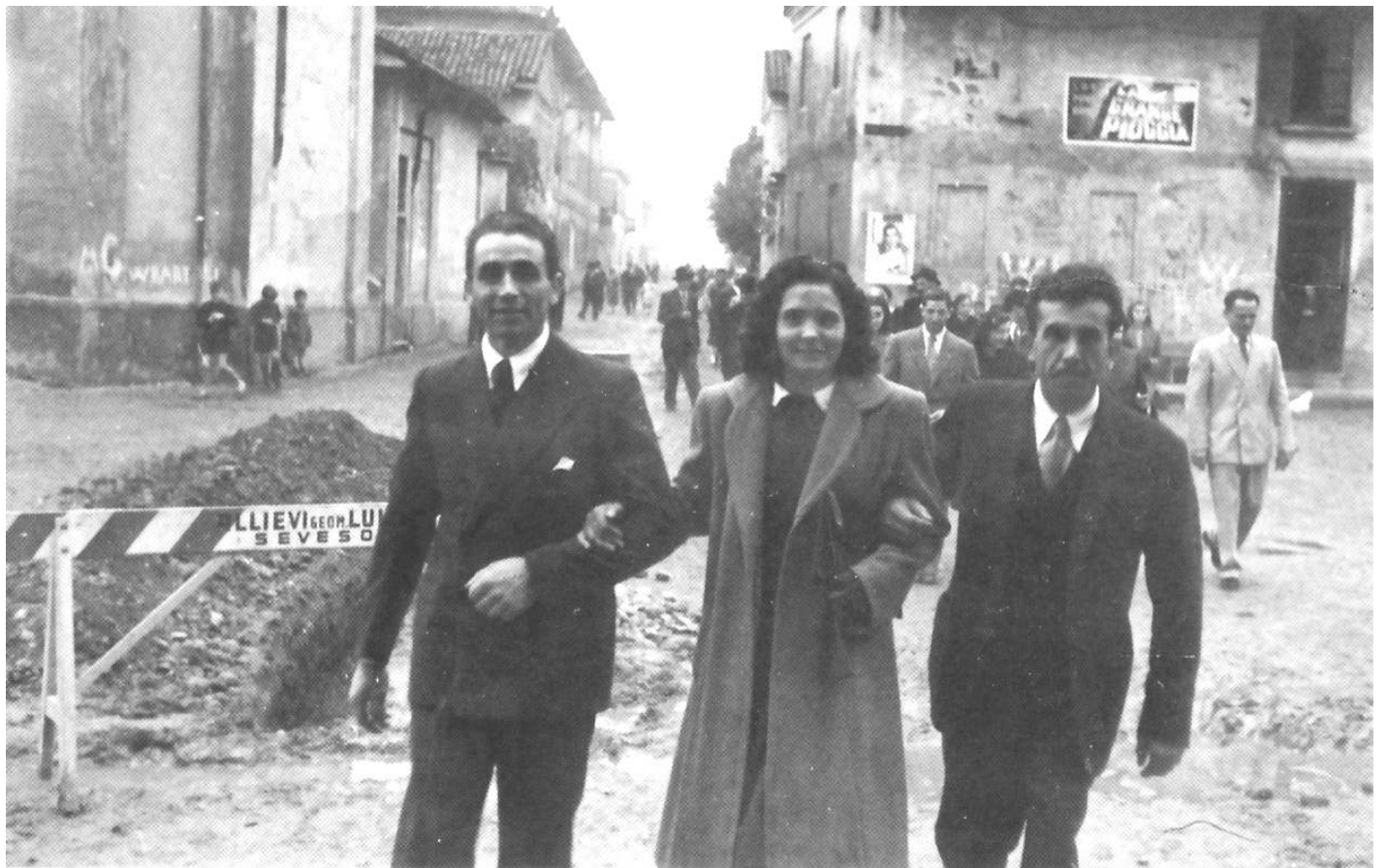
Inizio degli anni '50: Via Romanò e piazza IV Novembre durante i lavori per la costruzione della fognatura
